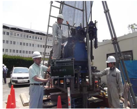
写真-3 GSサンプラーの挿入状況
